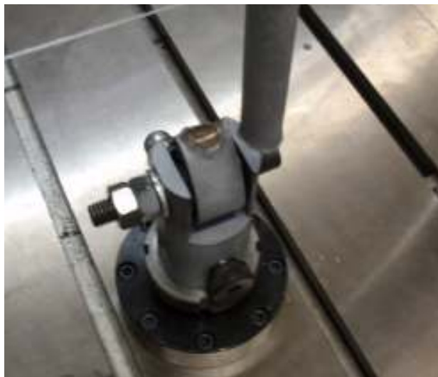
Slika 4: Pojava oštećenja na novim konstrukcijama AR spone
